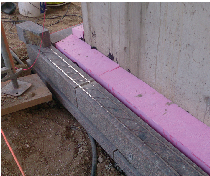
mit MURINOX®-Lagerfugenbewehrung verstärktes Mauerwerk
