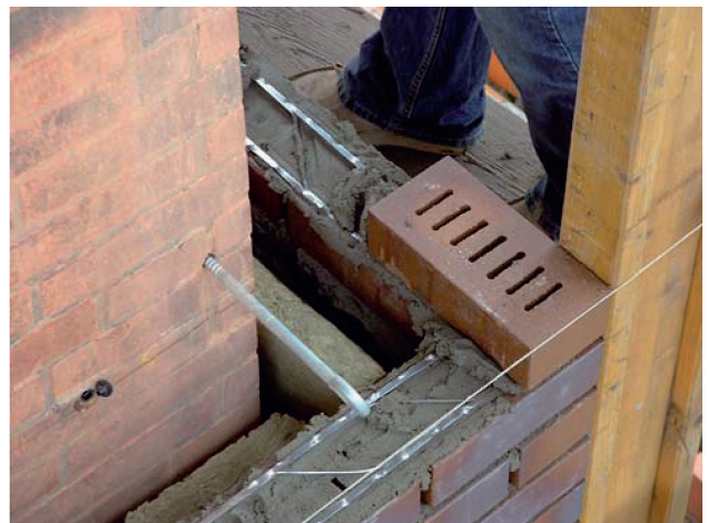
mit MURINOX®-Lagerfugenbewehrung verstärktes Mauerwerk
