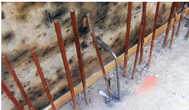
Zuganker im Einsatz auf der Baustelle.
